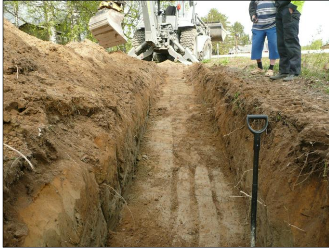
Jäljen kohta kaivannossa
