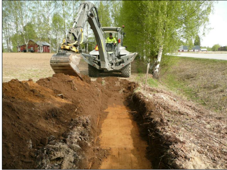
Kaivantoa kt.66:n länsipuolella
